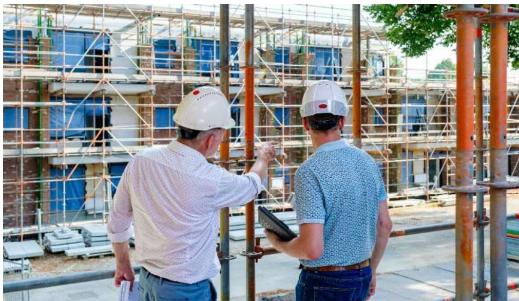
Medewerker en aannemer op bouwlocatie Rembrandtstraat
