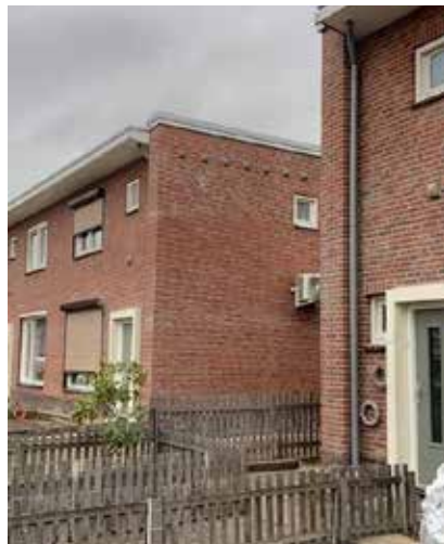
< Ridder van Heerstraat: gevels opnieuw gevoegd en gestraald en nieuwe voordeuren geplaatst.
