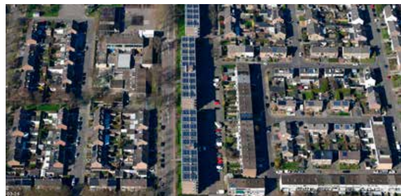
Burg. Kessensingel is in de afgelopen jaren verduurzaamd onder andere met zonnepanelen.
