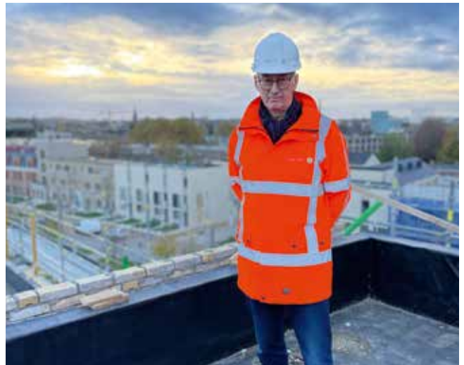
Collega Lerou Bastiaens op het nieuwe complex aan de Burgemeester Bauduinstraat
